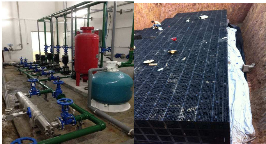
雨水处理设施 蓄水模块建设（示例）
