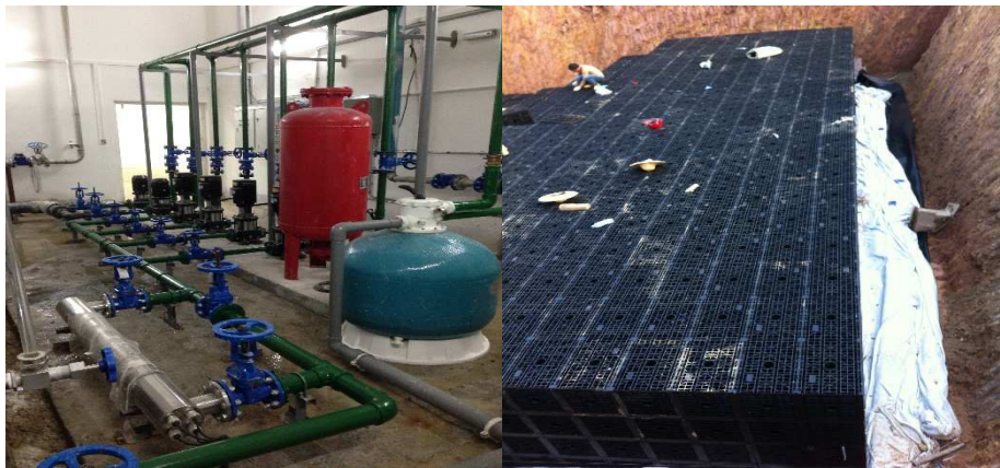
雨水处理设施 蓄水模块建设 (示例)
