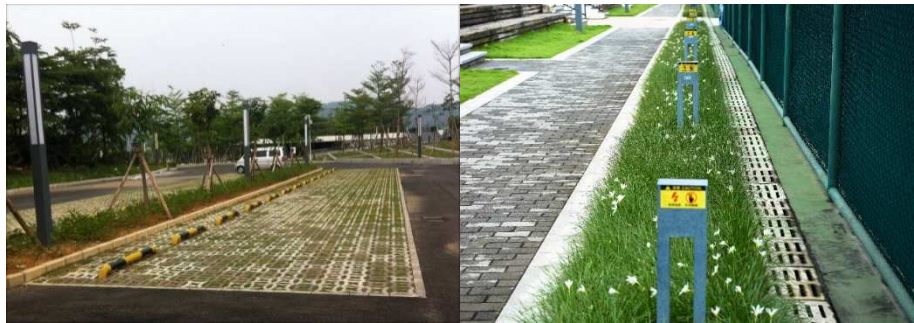
透水停车场 渗水路面、排水沟渠及生物滞留带
