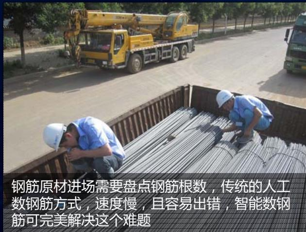
钢筋原材进场需要盘点钢筋根数，传统的人工数钢筋方式，速度慢，且容易出错，智能数钢筋可完美解决这个难题
