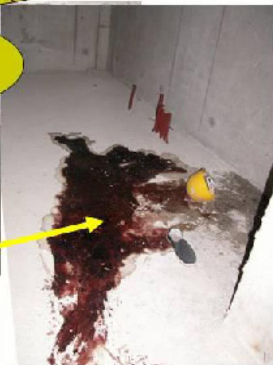
施工人员毛某正在施工现场东北侧19层电梯机房屋面进行屋顶风机的吊运，在消声器吊到楼顶的时候，毛某前去摘钩，因竖井无防护，毛某不慎掉下竖井，坠至17层地面。20分钟后医院急救人员赶到，经现场检查，毛某已经死亡。
