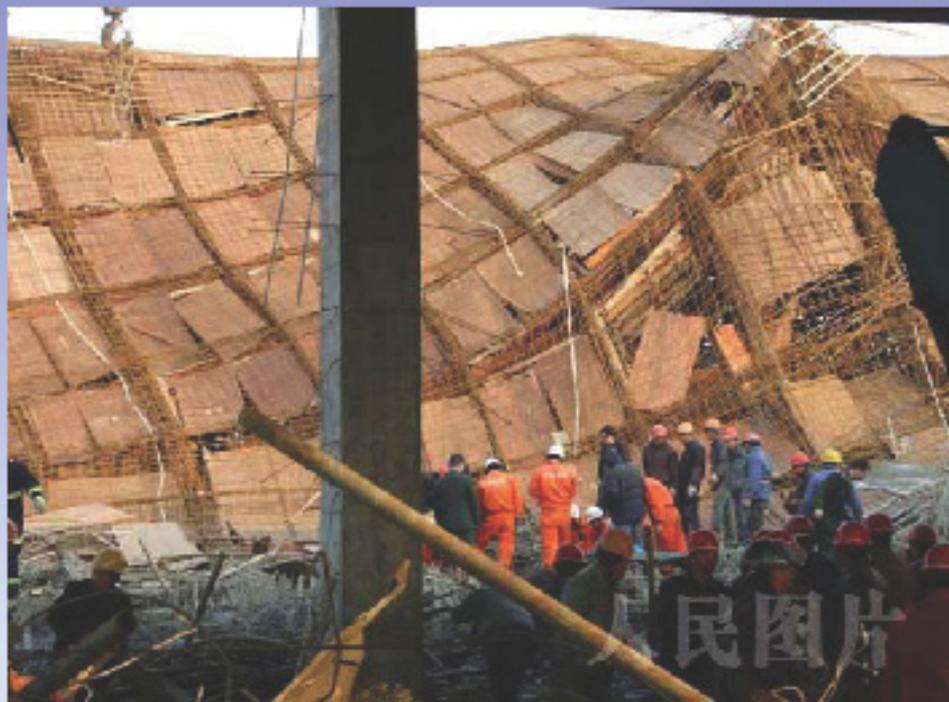
2010年1月12日中午11:50左右，安徽芜湖华强文化科技产业园配送中心工地在混凝土浇筑过程中发生模板支撑架坍塌事故，截至13日，已造成6死7伤。
