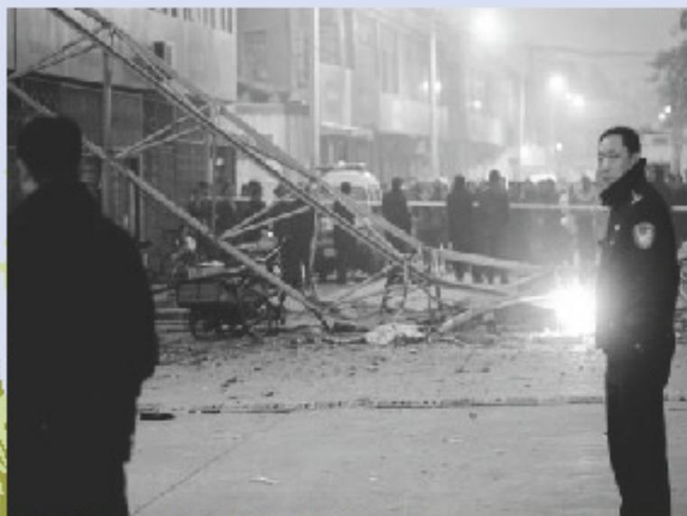
事故原因：工人们在给塔吊加高时操作发生失误、支撑失衡造成断裂的，工人培训力度不足。
