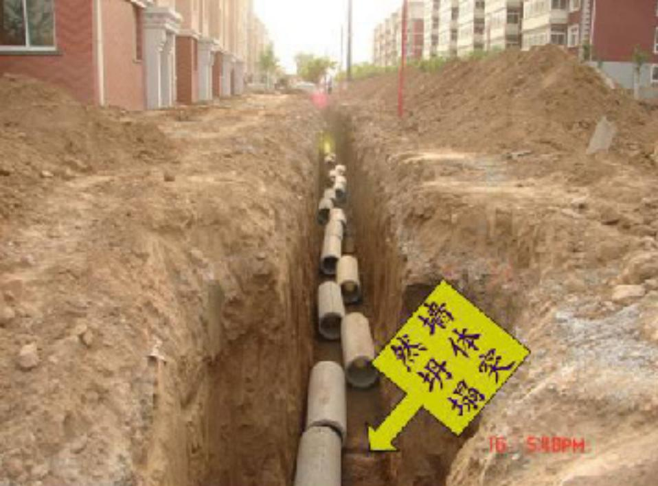
施工人員正在進行鋪設水泥管線施工時，污水溝中部偏東側溝的北壁突然坍塌，將正在溝底作業的施工人員埋壓致死。
