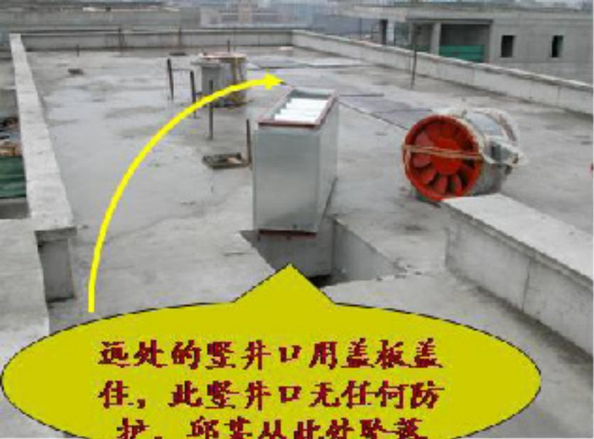
远处的竖井口用盖板盖住，此竖井口无任何防护，邱某从此处坠落
