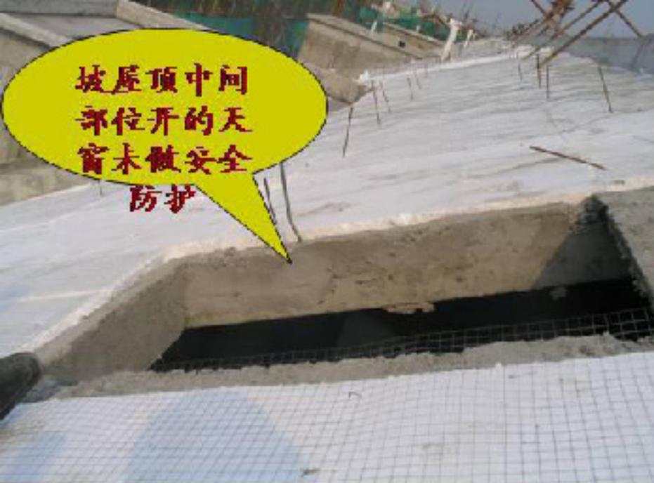
施工人员在坡屋顶进行保温工作时，不慎从天窗坠落至室内地面，落差4.5米，经抢救无效死亡。
