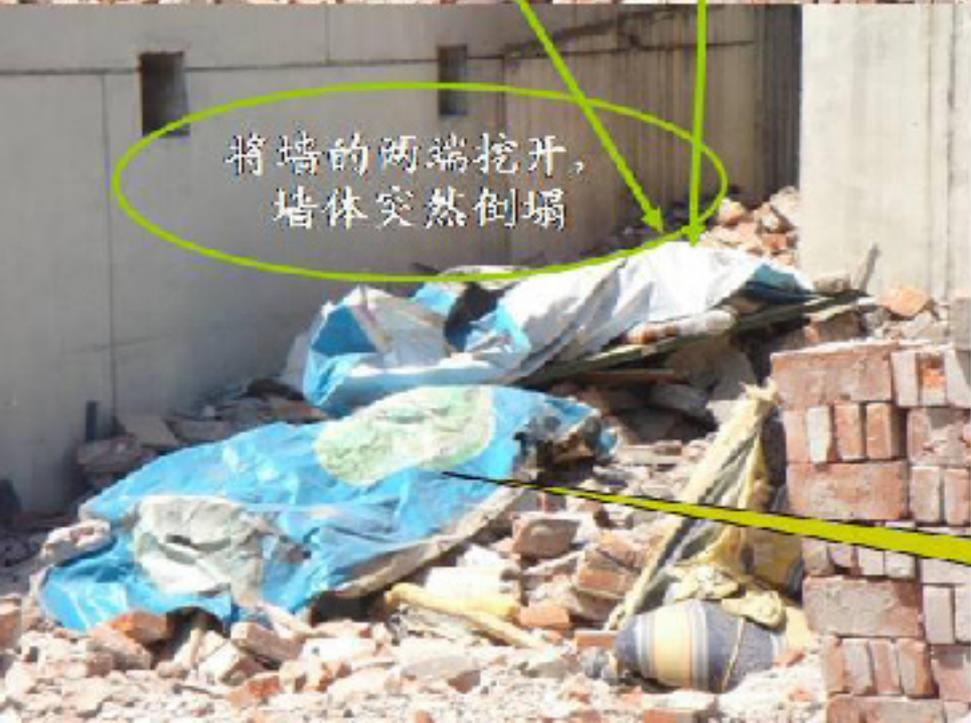
工长违章指挥，工人无知蛮干。违反作业程序和作业规定（建筑物结构必须采用机械设备进行拆除）进行拆除作业，两端开口的墙体突然倒塌，周某下跳到地面时，与正在旁边捡砖头的董某被倒塌的墙体砸中，当场死亡。
