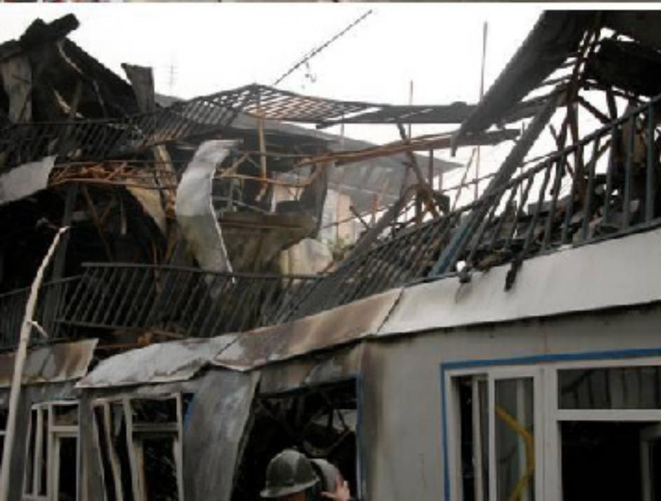
**施工人员违章使用电热器，离开后未断电，导致火灾事故发生，造成正在别的房间休息的人员死亡。**
