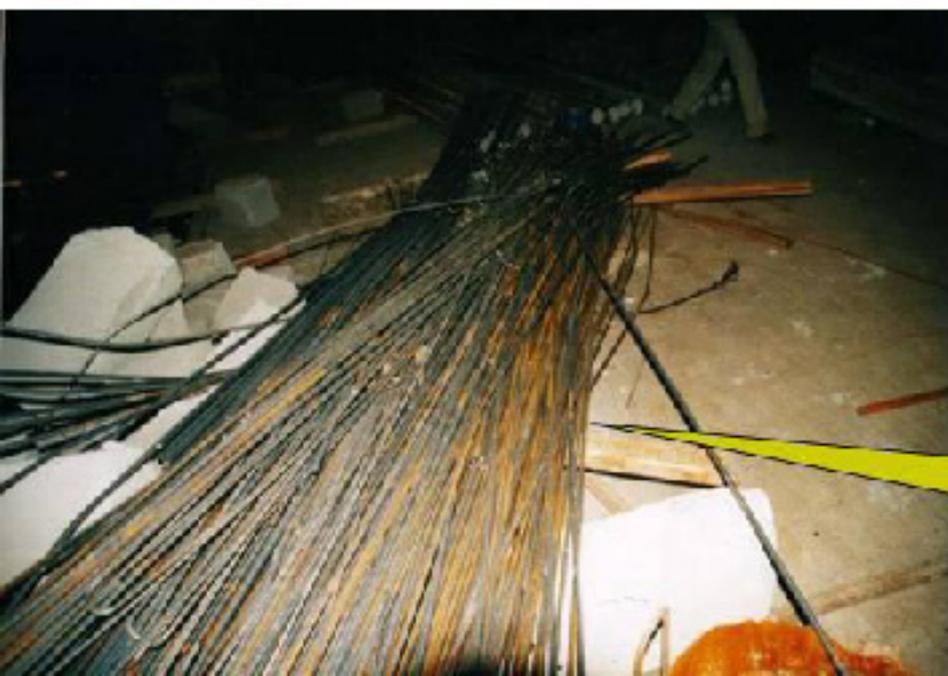
施工人员在使用塔吊吊运钢筋时，塔身突然折断，塔司死亡。事故的原因是超载导致塔式起重机的钢结构发生破坏，当时吊物重量已经达到额定载荷的213%
