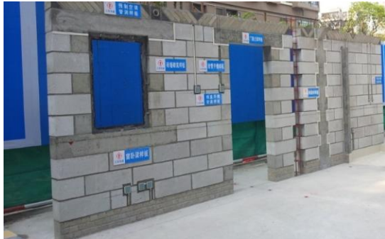
抹灰施工样板
