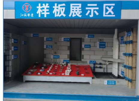
水电专业材料、土建专业砌筑工程样板等
