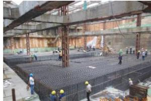
核心筒承台钢筋支架设计      核心筒钢筋绑扎
