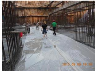
大体积混凝土测温点布置      混凝土薄膜养护
