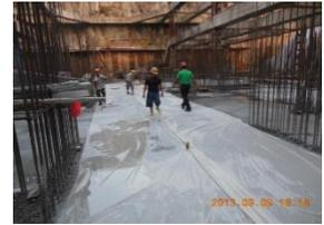
施工区雨水收集池 混凝土覆盖薄膜养护
