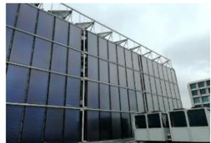
屋顶太阳能系统及空气源热泵
