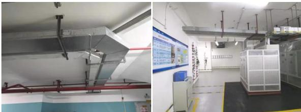
竖井强电桥架安装标准 配电箱布线合理
