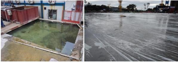
施工区雨水收集池 混凝土覆盖薄膜养护
