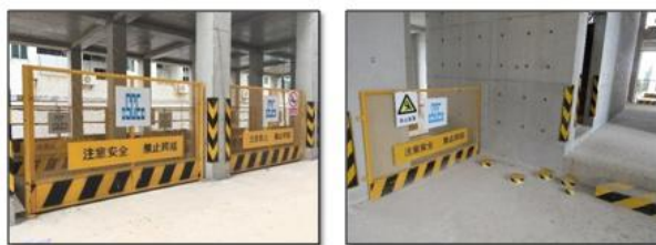
定型化外防护、墙防护及水电口防护
