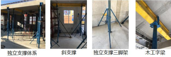
独立支撑体系 斜支撑 独立支撑三脚架 木工字梁
