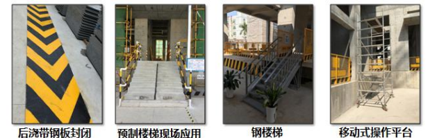
后浇带钢板封闭 预制楼梯现场应用 钢楼梯 移动式操作平台
