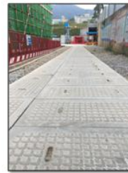
预制混凝土板铺路
