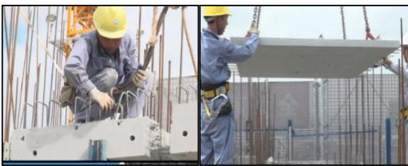
预制叠合梁吊装 → 预制叠合板吊装
