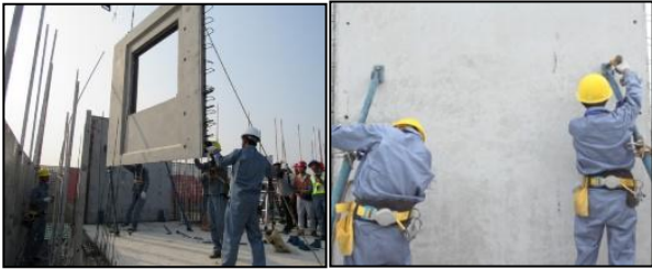
预制墙板吊装 → 临时固定 →
