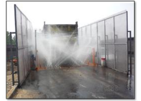
洗车槽循环用水
