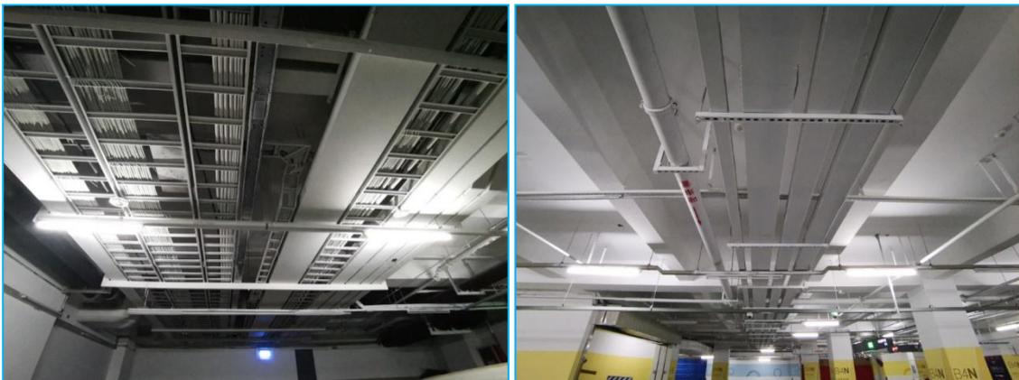
桥架安装顺直，连接规范，线缆敷设整齐
