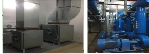
空调水泵安装规范
