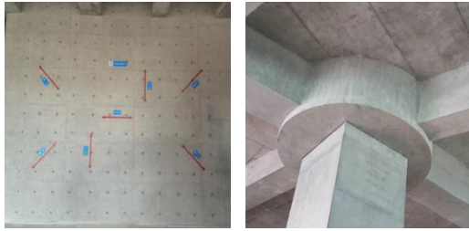
混凝土结构实体质量
