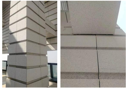
石材表面平整缝隙小
