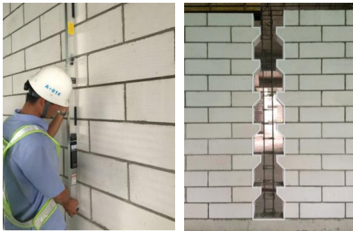
砌体砌筑规范 构造柱设置规范
