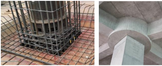
钢筋绑扎规范 结构混凝土观感良好
