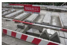
混凝土余料制作预制块
