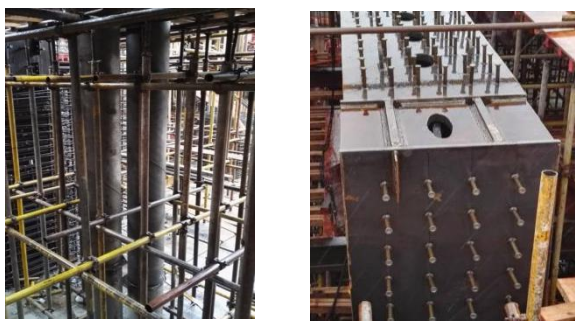
门诊楼屋面弧形花架梁 门诊楼弧形玻璃幕墙
