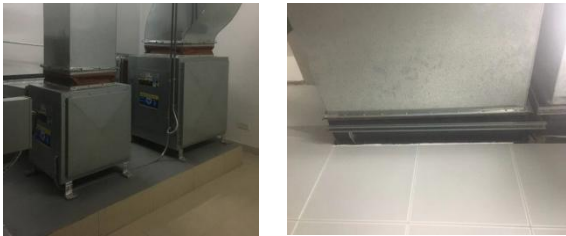
空调机房基础
