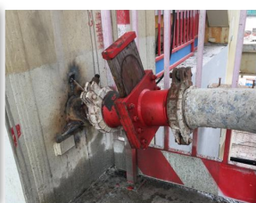
高层高楼层顶升法浇筑钢管砼
