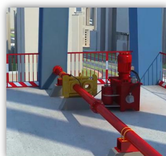
高层高楼层顶升法浇筑钢管砼
