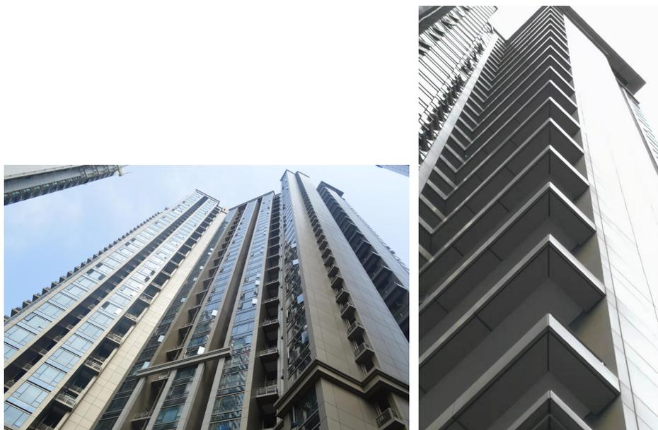
7、室外石材构件干挂工艺精良，整料定尺加工、拼接细致、对缝工整，胶缝顺直饱满。
