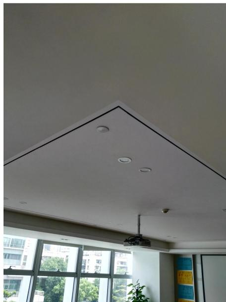
3、过道通长吊顶，合理设置灯池、墙侧伸缩缝、转角变形缝等抗裂措施，无裂缝。
