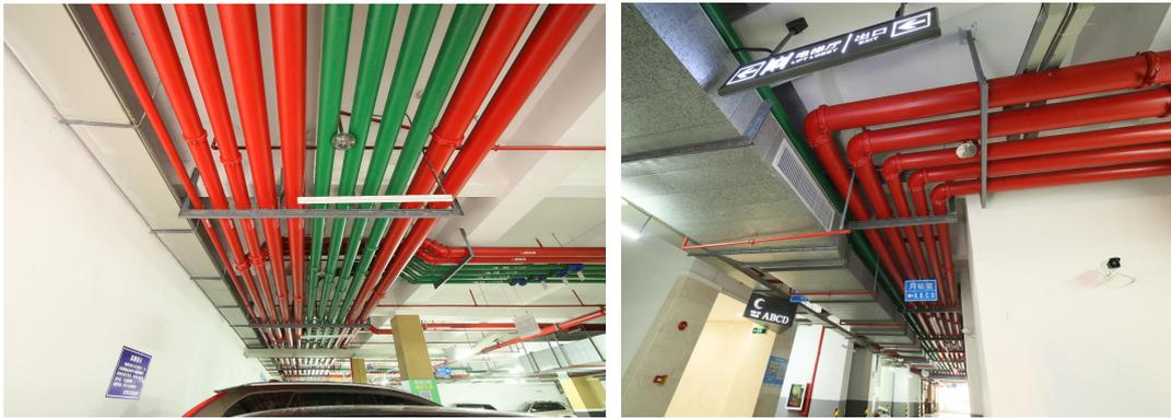
14、设备房管线布置采用 BIM 深化设计，布局合理，每台设备均有二维码标识，便于管理维护。
