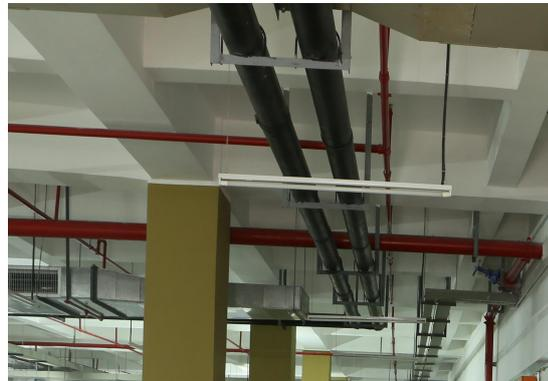
消防管道采用镀锌钢管，管道阀门均进行了强度、严密性试验，试验合格。
