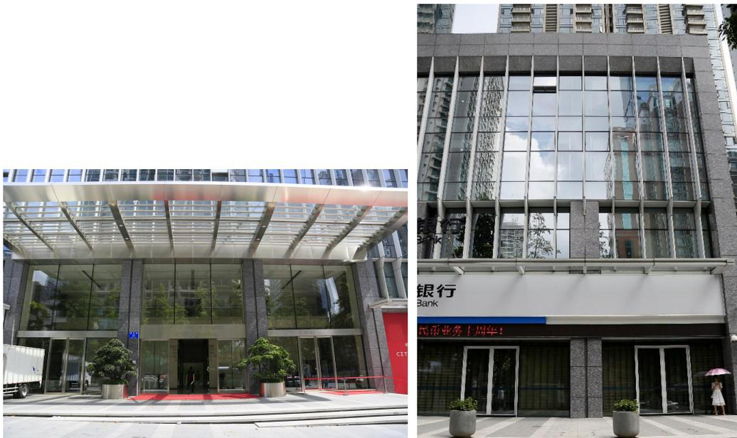
香槟色铝板幕墙与铝合金外窗、空调机位、阳台栏杆统一策划，衔接自然，对缝工整。
