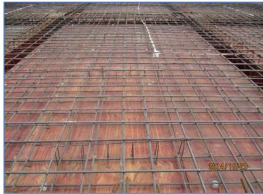
(2) 内架搭设规范牢固，模板拼接严密无缝隙透光。
