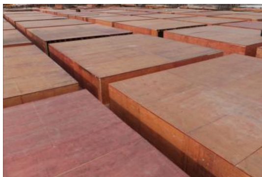
主体结构模板安装
