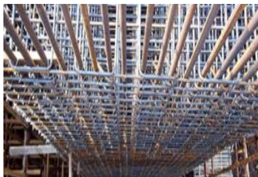
主体结构钢筋绑扎
