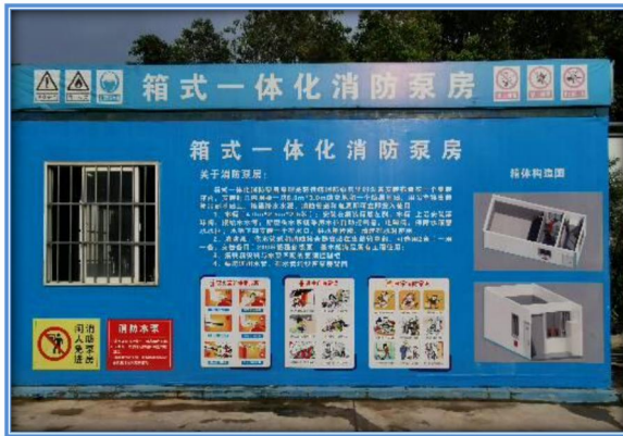
集装箱式集成消防水泵房
