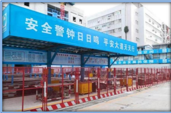
钢筋加工房材料堆放及区域划线
