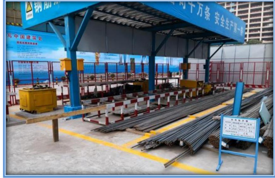
钢筋加工房材料堆放及区域划线
