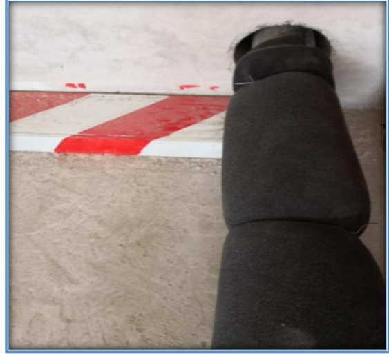
泵管隔音包裹
