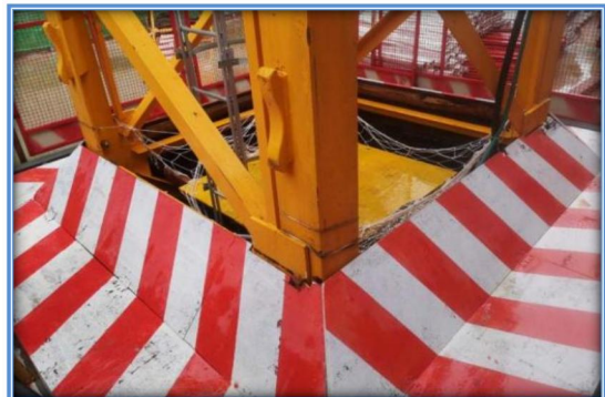
塔吊预留洞口防护
