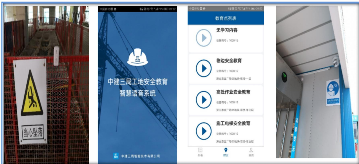
使用感应安全语音提示器及智能语音系统辅助现场安全管理
