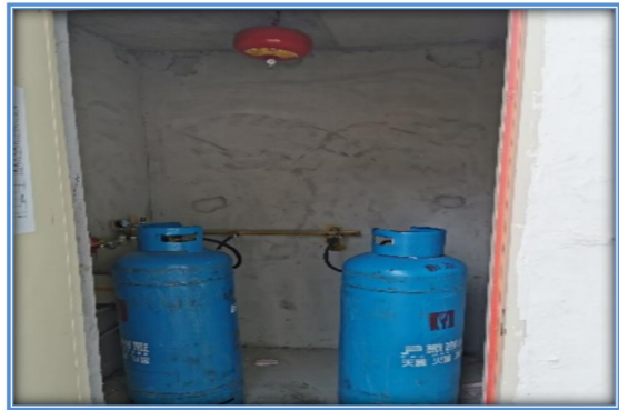
库房设置烟感报警装置及悬挂式自动灭火器
