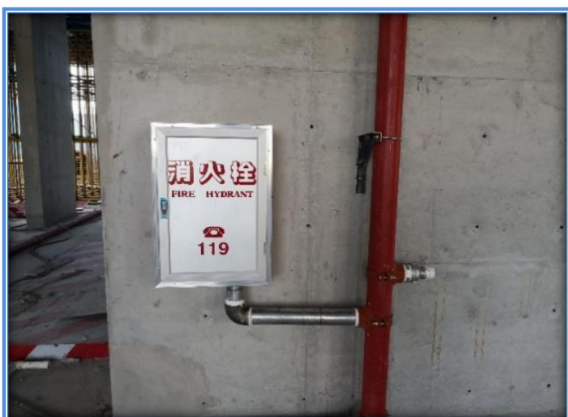
永临结合消防
