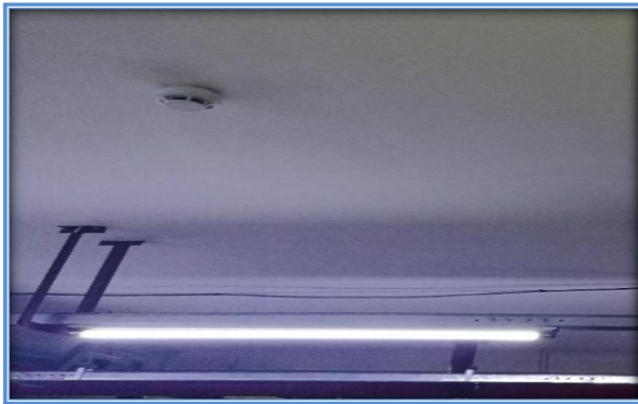
库房设置烟感报警装置及悬挂式自动灭火器
