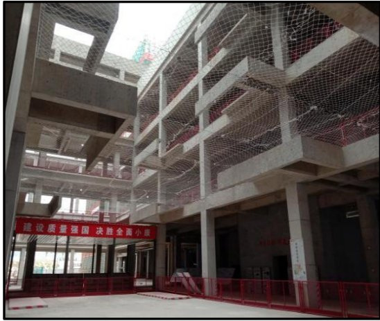
临空平网防护
