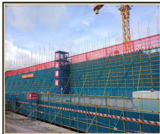
脚手架剪刀撑及横向斜撑
