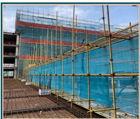
脚手架杆件设置
