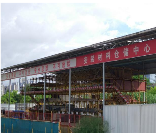
安装材料仓储中心
