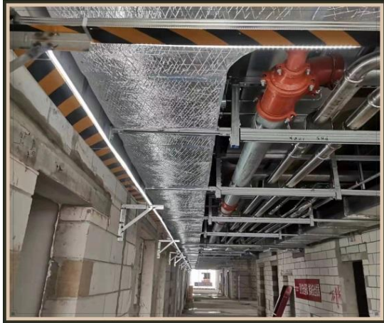
临时用电敷设桥架
