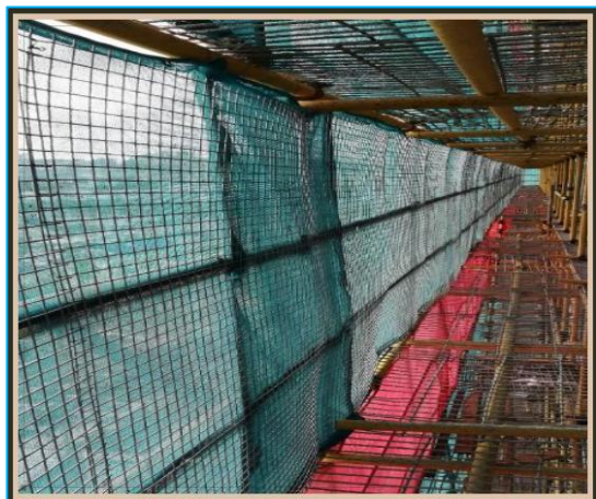
作业层外架安全网挂设钢丝网
