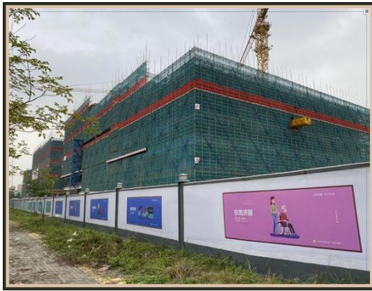
施工围挡与外架全封闭
