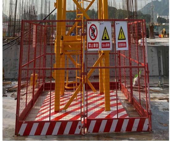
塔吊预留洞口防护
