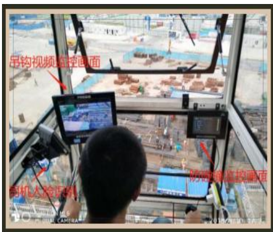
塔吊操作可视化
