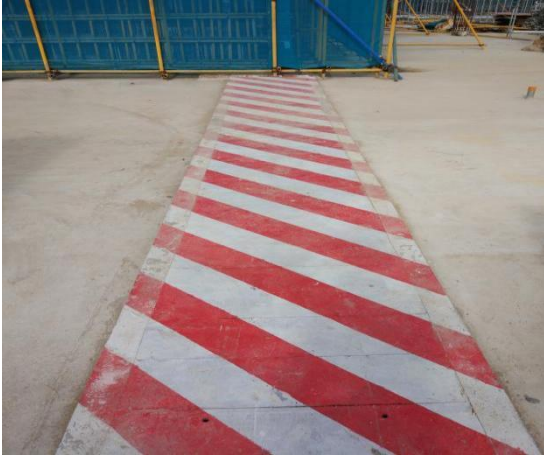
后浇带硬防护封闭
