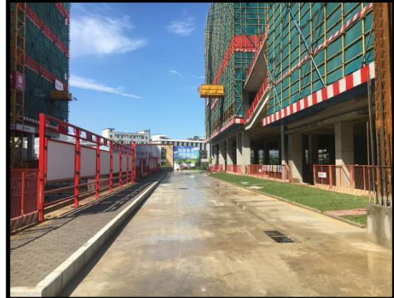
场地硬底化(永临结合)
