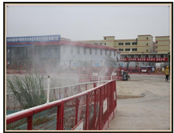
易起尘作业湿法施工
