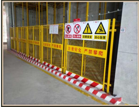
临边洞口防护
