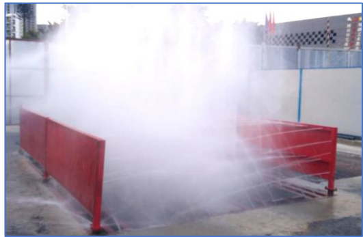
自动化喷淋洗车槽
