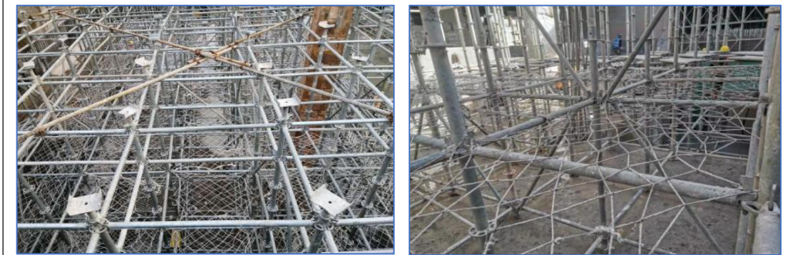
高大模板支撑（最大支撑高度 7.8m，搭设跨度 10.6m）
