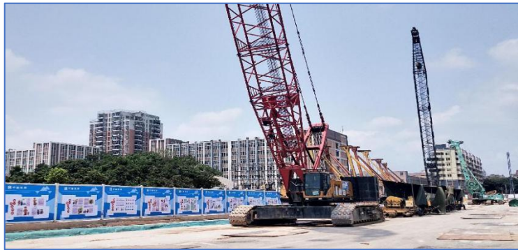
地下连续墙导墙防护
