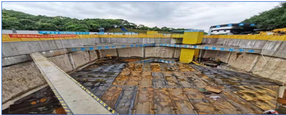
竖井厂棚化施工
