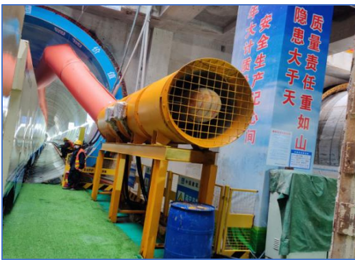
隧道送风机、通风管及隧道水管
