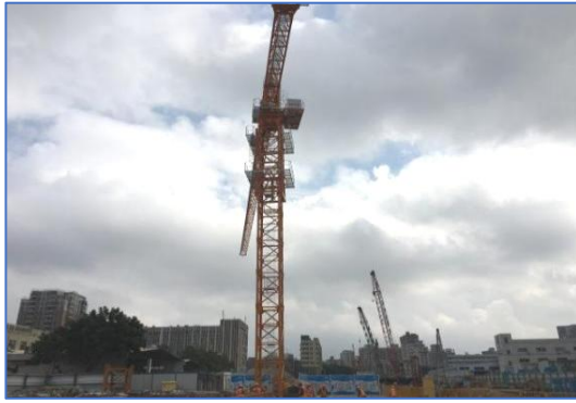
塔机独立状态的计算高度最高达到 65m
