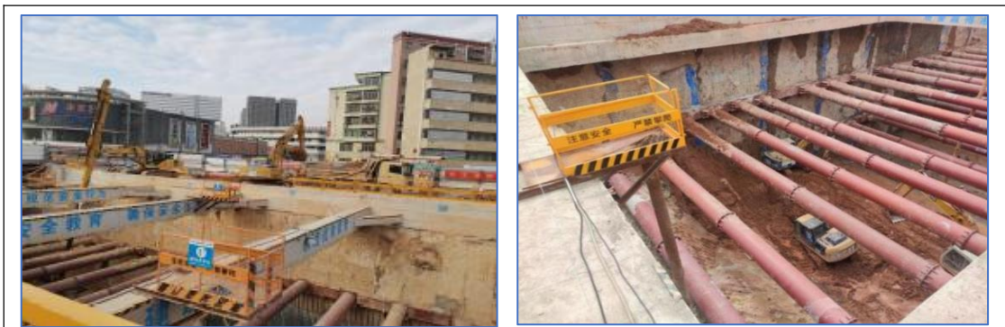
深基坑支护采用砼支撑、钢支撑作为支护方式，最大开挖深度达 19m
