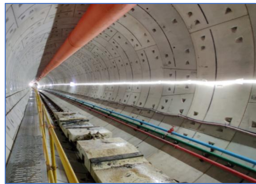
隧道送风机、通风管及隧道水管
