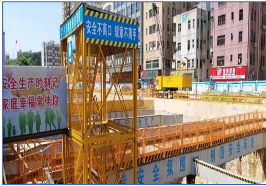
人行通道防护与支撑梁防护
