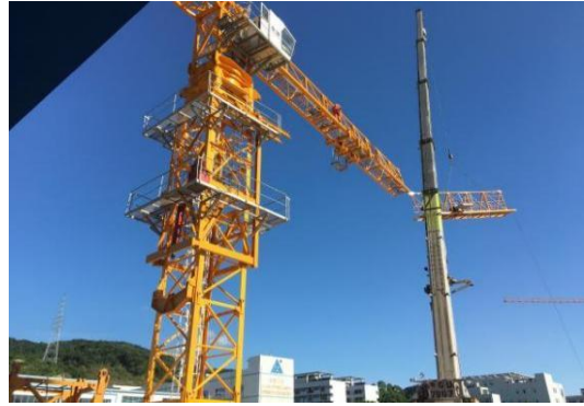
塔机独立状态的计算高度最高达到 65m
