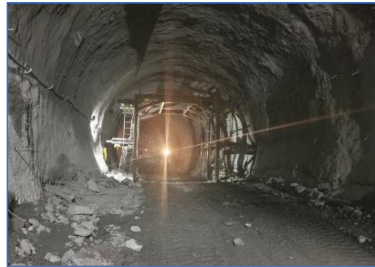
矿山法隧道开挖及支护（矿山法隧道开挖及支护 234 米）
