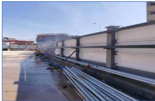
施工围挡及外架喷淋 100%全封闭
