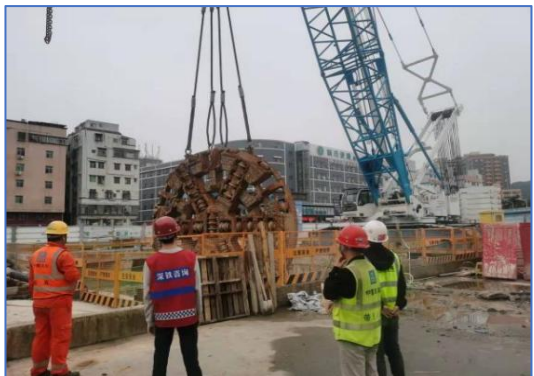
盾构机组装下井及拆卸调出
