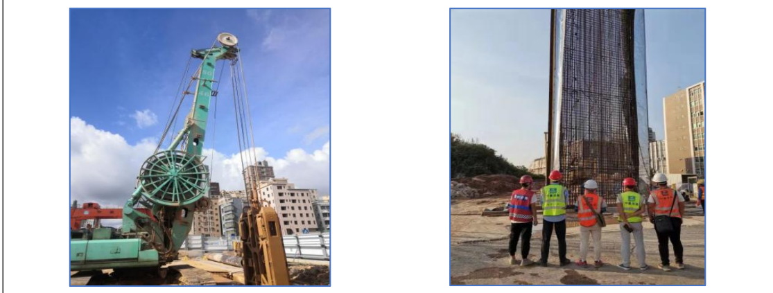
地连墙成槽及钢筋笼吊装（钢筋笼最大重量达 200KN）
