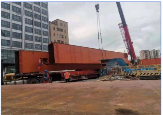
龙门吊安装及拆除
