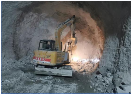
矿山法隧道开挖及支护（矿山法隧道开挖及支护 234 米）
