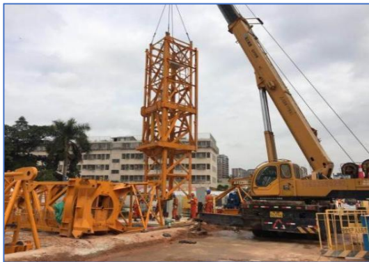
塔吊的安拆及验收
