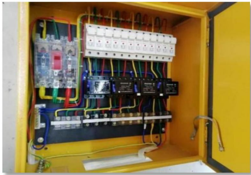
现场动力电缆线与照明电缆线分开设置，大型设备用电单独计量
