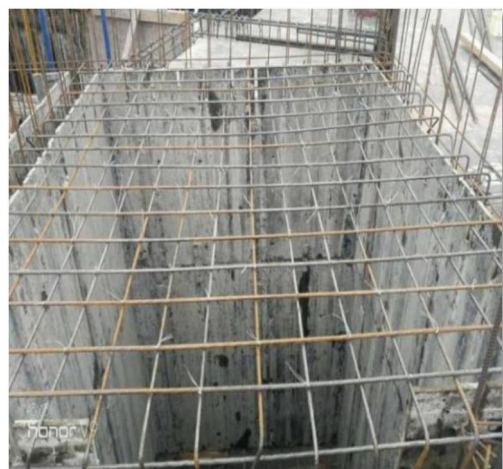
临边、洞口防护标准化，拆装方便，可周转使用，节约材料。楼层内电梯洞口防护，预留单层双向钢筋，防护牢靠，张贴警示牌，确保作业人员安全
