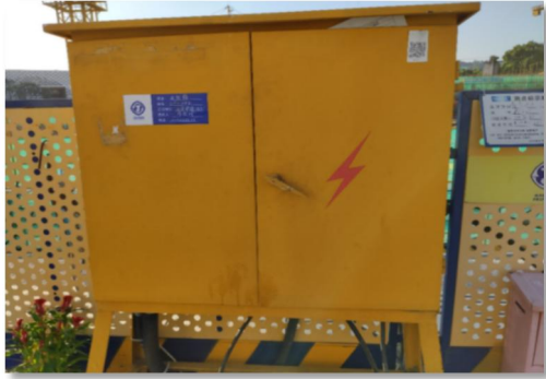
现场电箱按要求设置，箱内贴有电路图和巡查记录表，专业电工每日进行巡查
