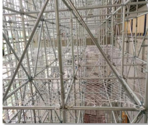
模板支撑体系采用承插型盘扣式脚手架
