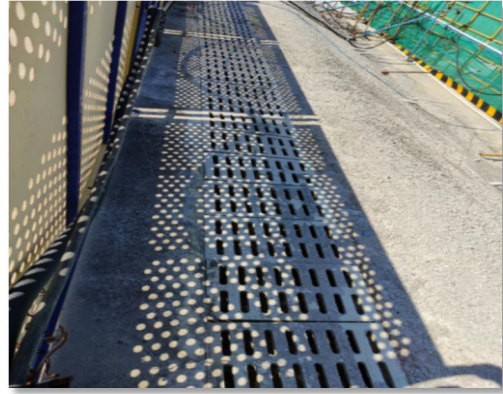
施工现场采用标准化加工棚，周边设置排水沟和三级沉淀池
