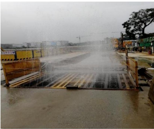
现场出入口设置冲洗设施，积极执行深圳市相关文件精神，现场使用新型泥头车
