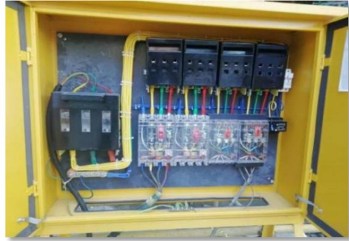
现场电箱按要求设置，箱内贴有电路图和巡查记录表，专业电工每日进行巡查
