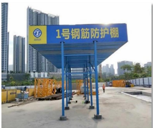
现场机械、设备防护棚采用标准化工具式防护棚，四周做好安全宣传标语、张挂警示牌。
