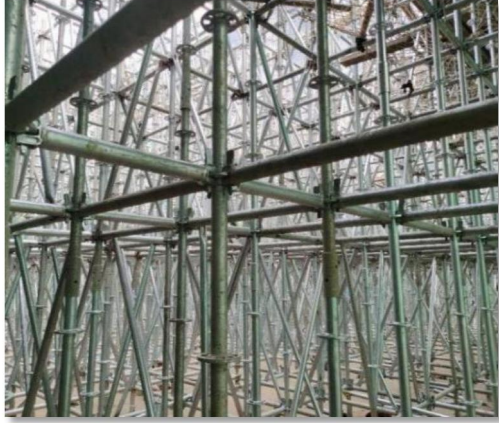
模板支撑体系采用承插型盘扣式脚手架
