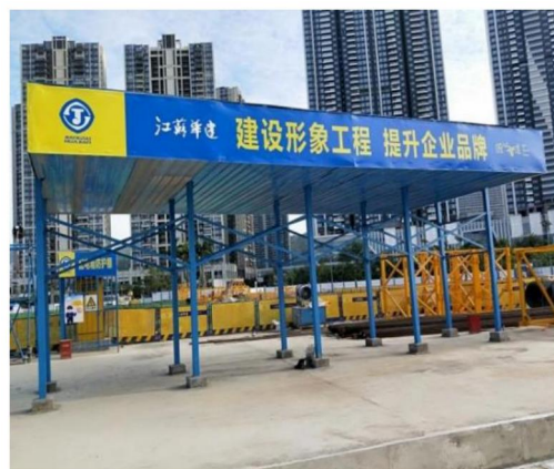
现场机械、设备防护棚采用标准化工具式防护棚，四周做好安全宣传标语、张挂警示牌。
