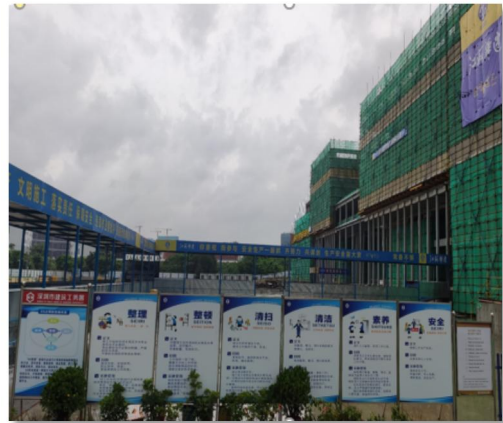
现场安全通道、施工电梯通道采用标准化工具式防护棚，四周做好安全宣传标语、张挂警示牌
