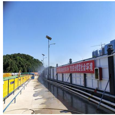
施工现场采用标准化加工棚，周边设置排水沟和三级沉淀池
