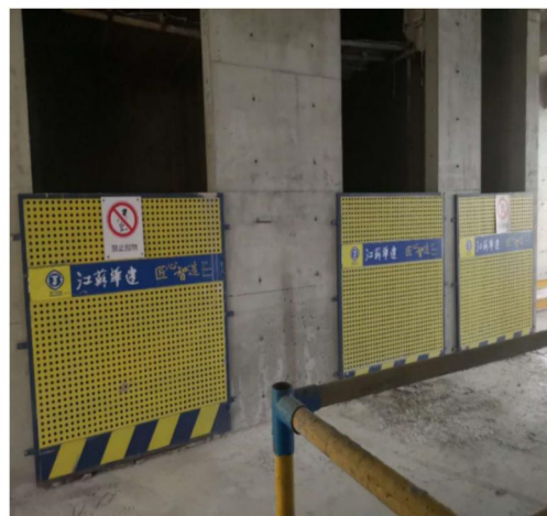
临边、洞口防护标准化，拆装方便，可周转使用，节约材料。楼层内电梯洞口防护，预留单层双向钢筋，防护牢靠，张贴警示牌，确保作业人员安全
