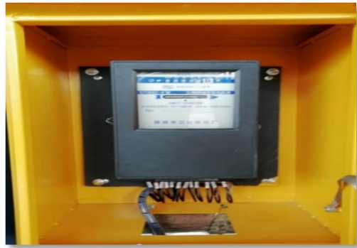
现场动力电缆线与照明电缆线分开设置，大型设备用电单独计量
