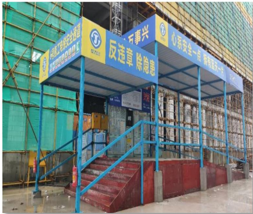
现场安全通道、施工电梯通道采用标准化工具式防护棚，四周做好安全宣传标语、张挂警示牌
