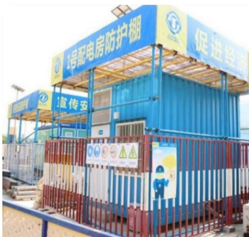
现场配电房、配电柜按规范要求设置，电路图及巡查记录表上墙，专业电工每日进行巡查
