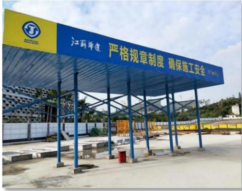
施工现场采用标准化加工棚，周边设置排水沟和三级沉淀池
