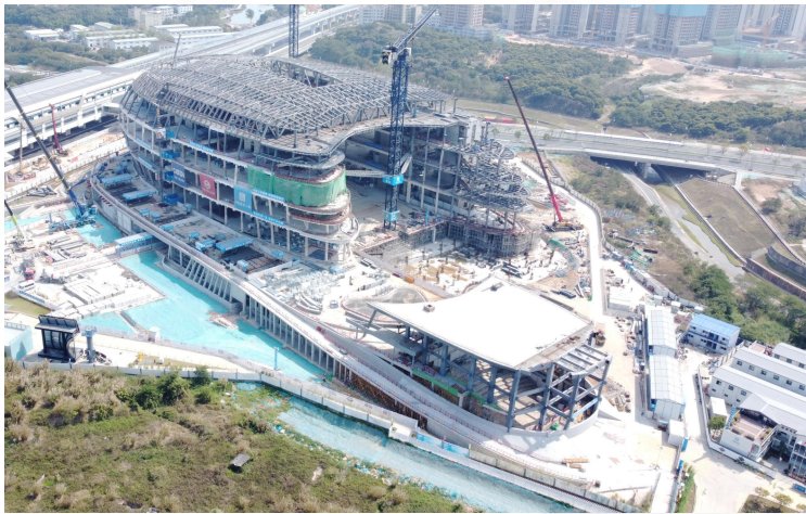
现场结构照片
