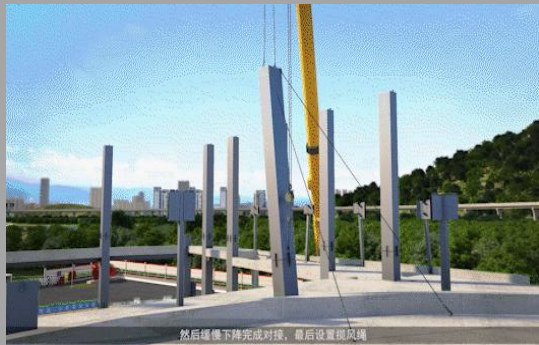
屋面影院大跨度钢梁安装可视化
