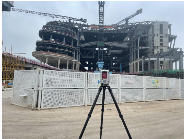
现场三维扫描
