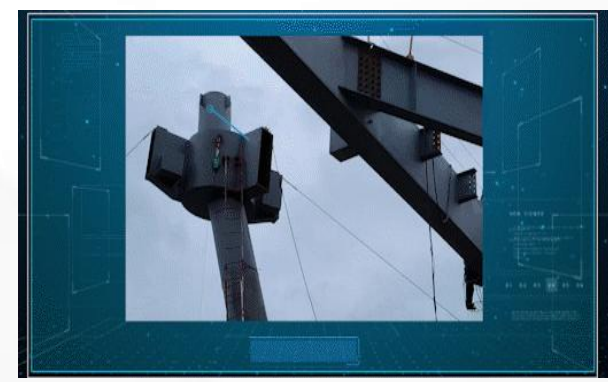
现场实施安装
