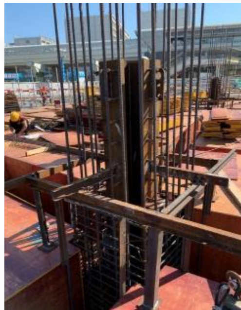
现场实施安装
