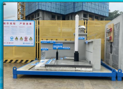
现场屋面质量样板
