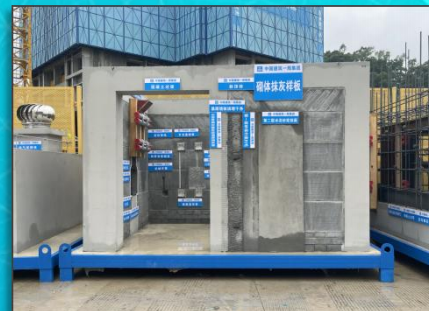
现场砌体抹灰样板
