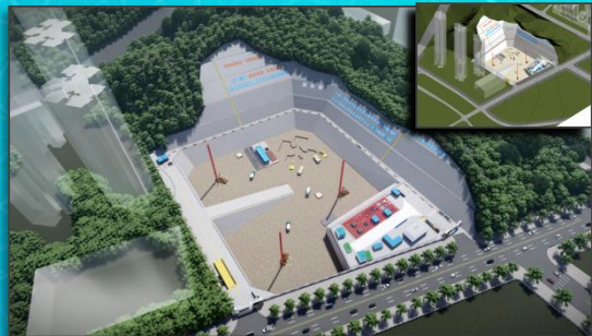
工程桩及天然地基开挖施工阶段
