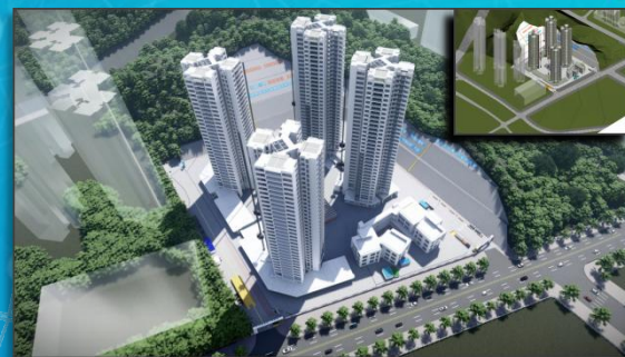
机电安装及装饰装修施工阶段
