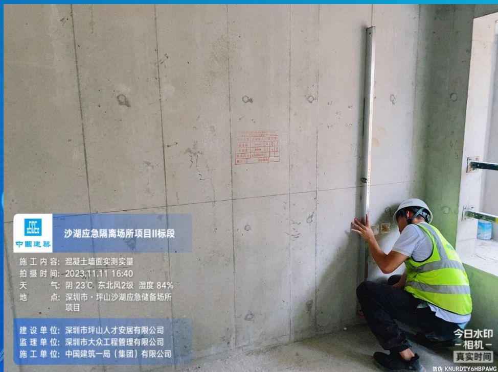
智能靠尺现场应用
