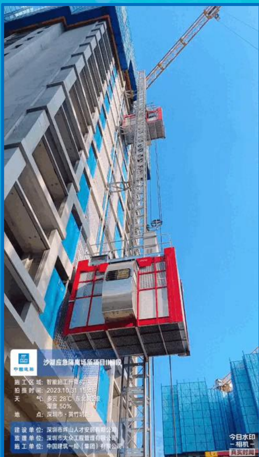
施工升降机运行
