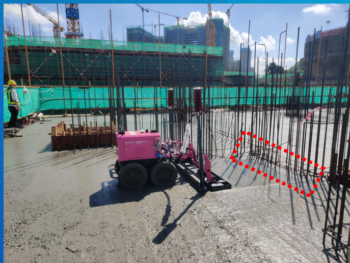
靠近墙柱处人工收面
