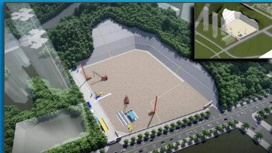
支护桩及微型桩施工阶段
