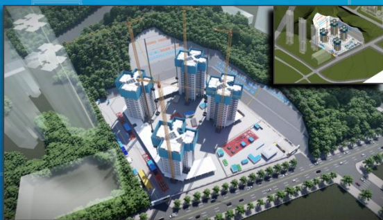
主体结构施工阶段
