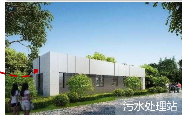
高压氧气站、垃圾站
