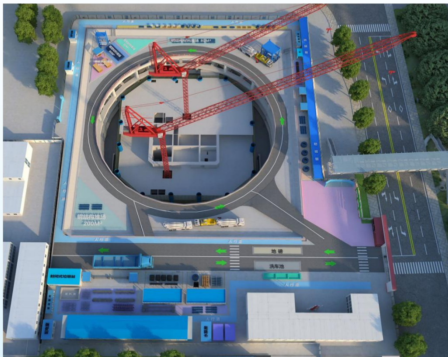
现场塔吊设置
