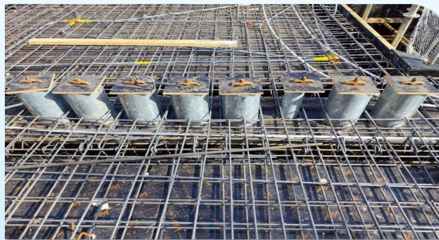
现场BIM管井预留洞成果落实
