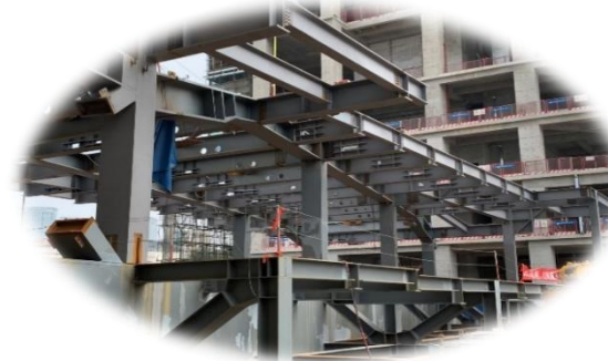
施工现场拼装
