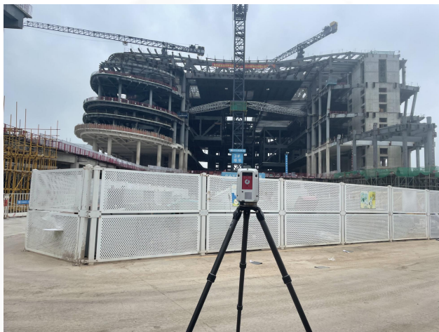
现场三维扫描
