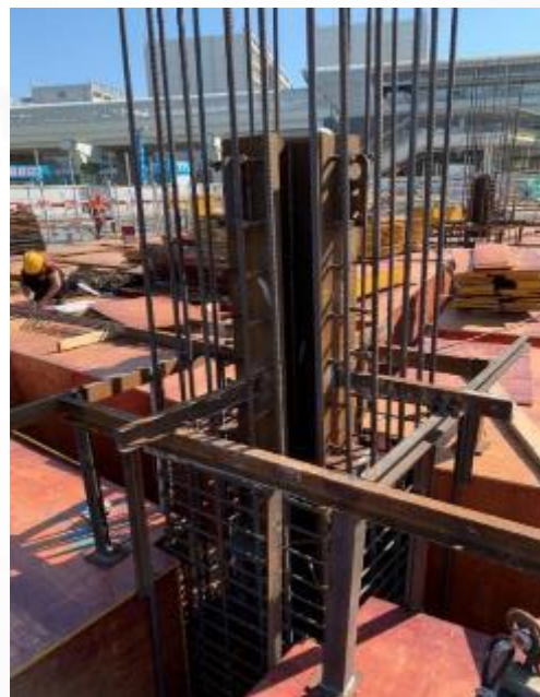
现场实施安装
