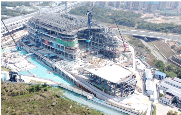
现场结构照片
