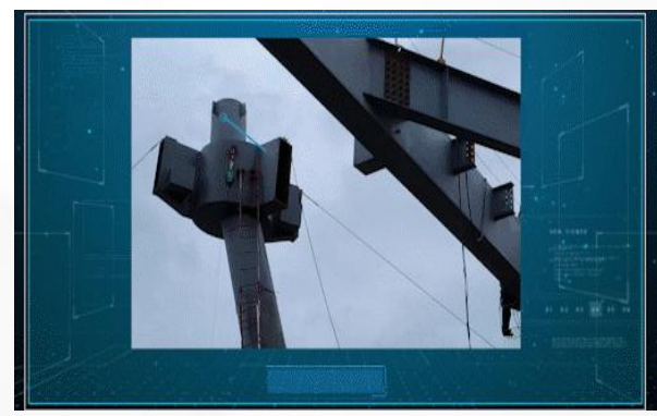
现场实施安装
