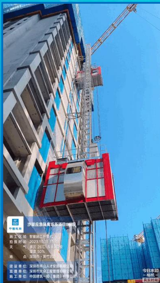
施工升降机运行
