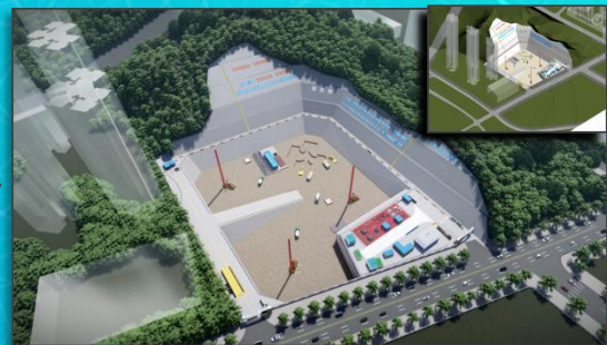
工程桩及天然地基开挖施工阶段
