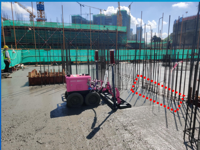
靠近墙柱处人工收面
