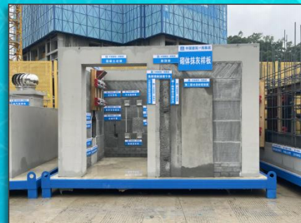
现场砌体抹灰样板
