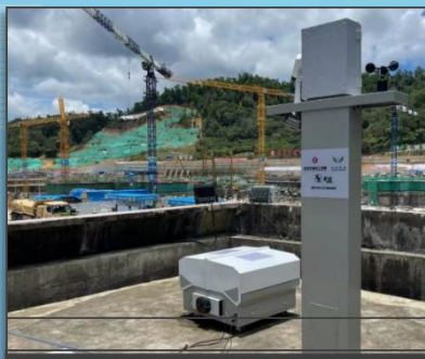
无人值守参巡模块 室外建造现场数据采集和巡查
