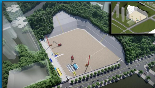
支护桩及微型桩施工阶段
