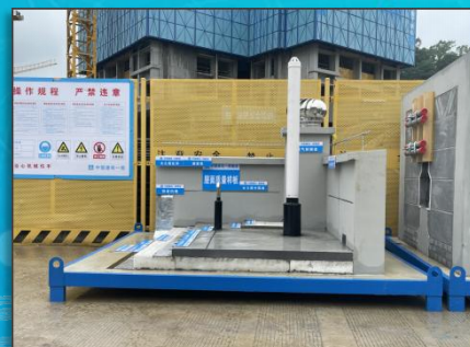
现场屋面质量样板
