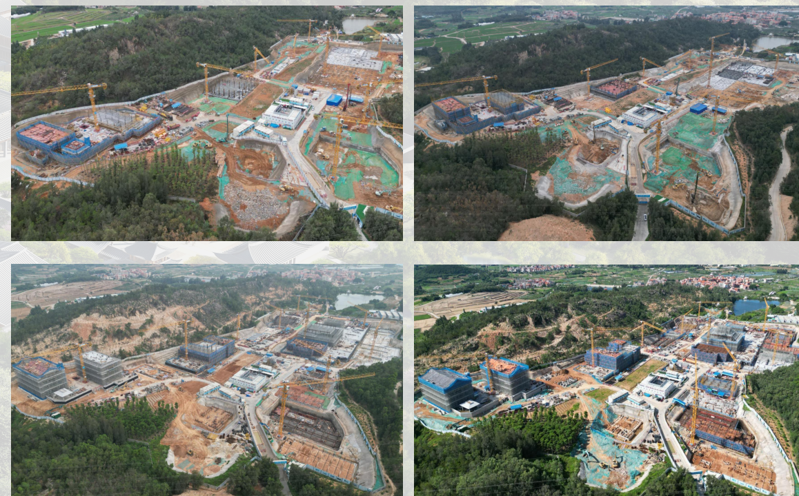
无人机进度管控
