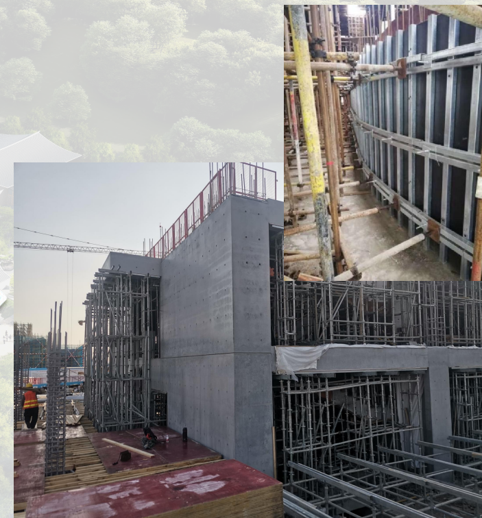
清水混凝土现场实施
