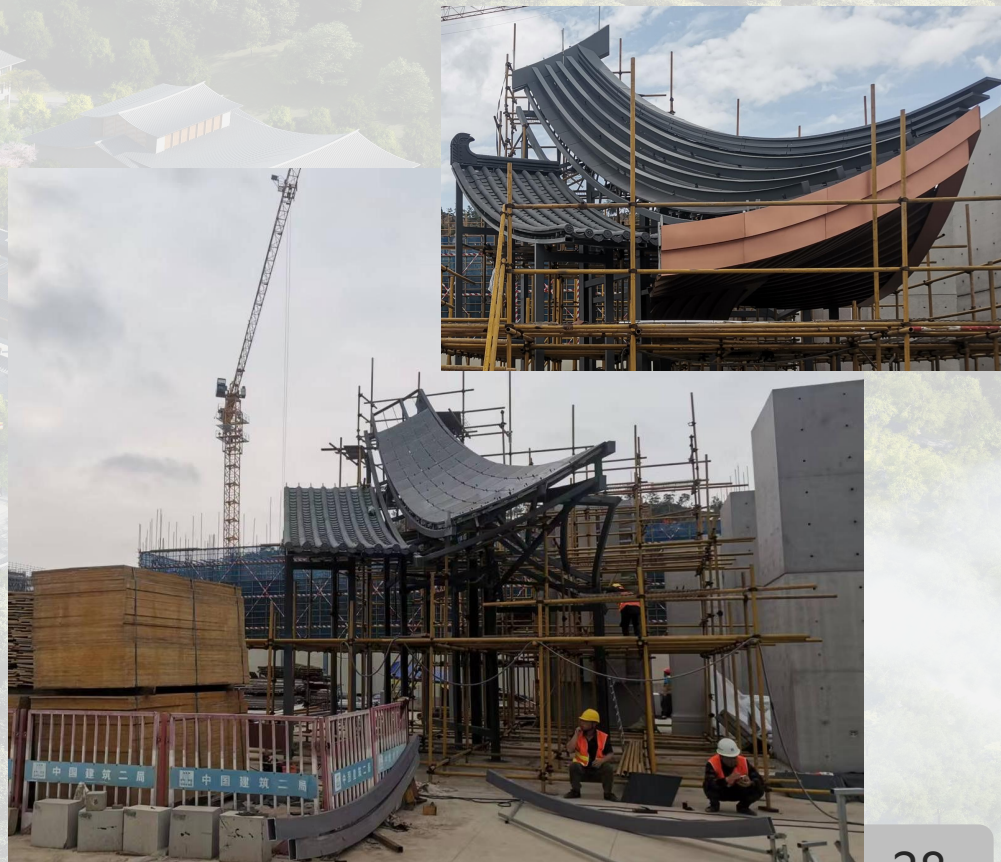
幕墙样板现场实施
