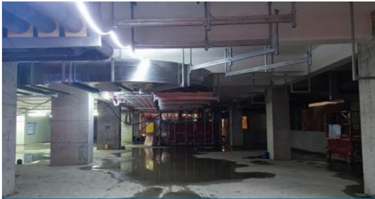
现场施工情况
