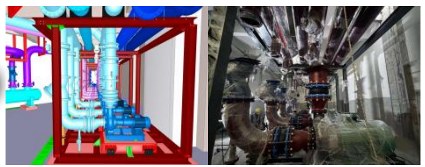
01. 机组就位及支架安装 02. 水平管段装配 03. 接口管道装配
