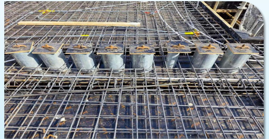
现场BIM管井预留洞成果落实
