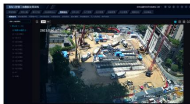
辅助现场施工
