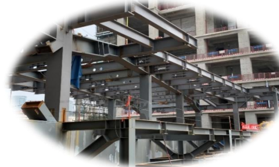
施工现场拼装
