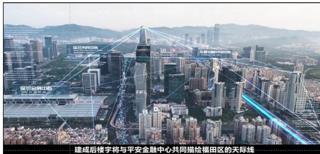
深圳金融科技研究院项目位于福田CBD中央商务区
